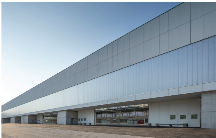
Fig. 12 | Foto tamponamenti del Padiglione dall'esterno © HG Esch
