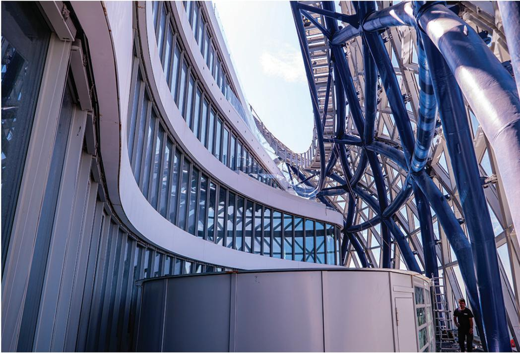
Fig. 5 | Diagrid e facciata sopra il livello 20 (Foto Marco Garofalo)
