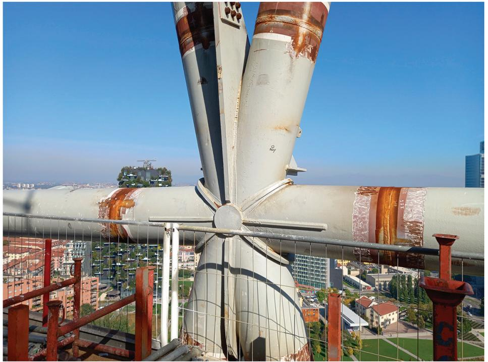
Fig. 22 | Immagine del nodo in officina e installato in cantiere
