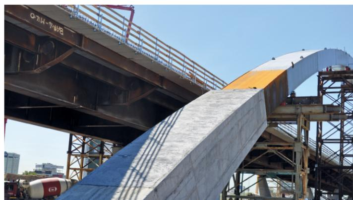
Fig. 36 - Arco EXPO 2 - Completamento montaggi
