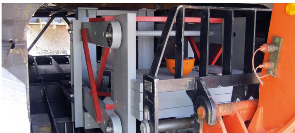
Fig. 34 - Il TMD in fase di installazione - in primo piano la massa oscillante posta sul telaio mobile
