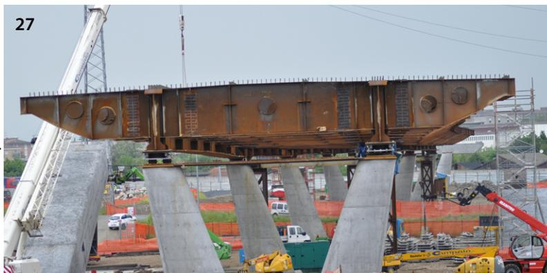
Fig. 25 - Viadotto "EXPO" - Sezione trasversale. Fig. 26 - Viadotto "EXPO" - Sezione trasversale tipica intermedia. Fig. 27 - Viadotto "EXPO" - Vista d'assieme lato ponte ad arco su A4 della carpenteria metallica e delle pile
