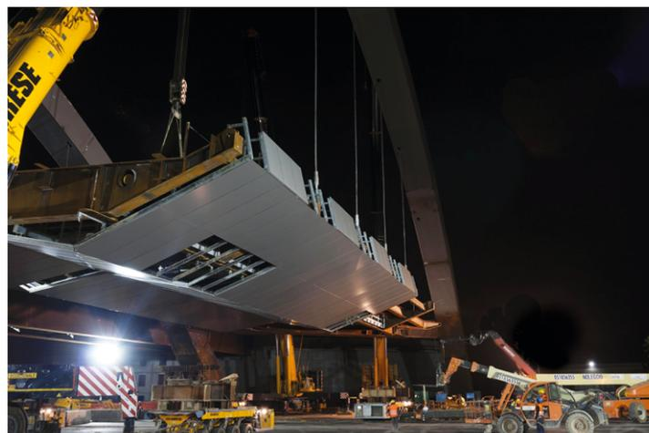
Fig. 13 - Varo del primo macroconco di impalcato sospeso sopra l'autostrada A4
