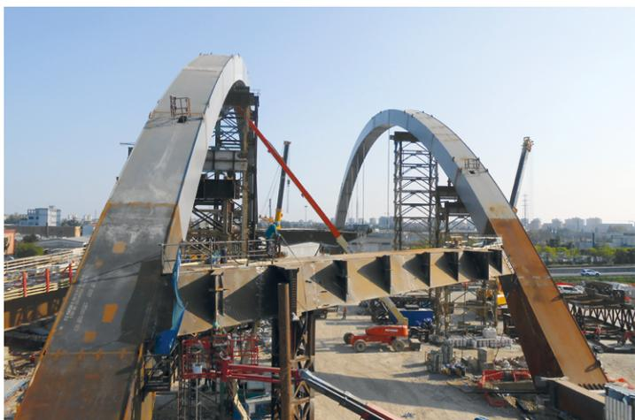
Fig. 12 - Vista degli archi A4 in fase di montaggio con in primo piano il traverso di collegamento
