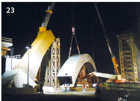
Fig. 23 - Varo notturno del macroconco 4 dell'arco su autostrada A8. Fig. 24 - Varo notturno del macroconco centrale dell'impalcato sull'autostrada A8
